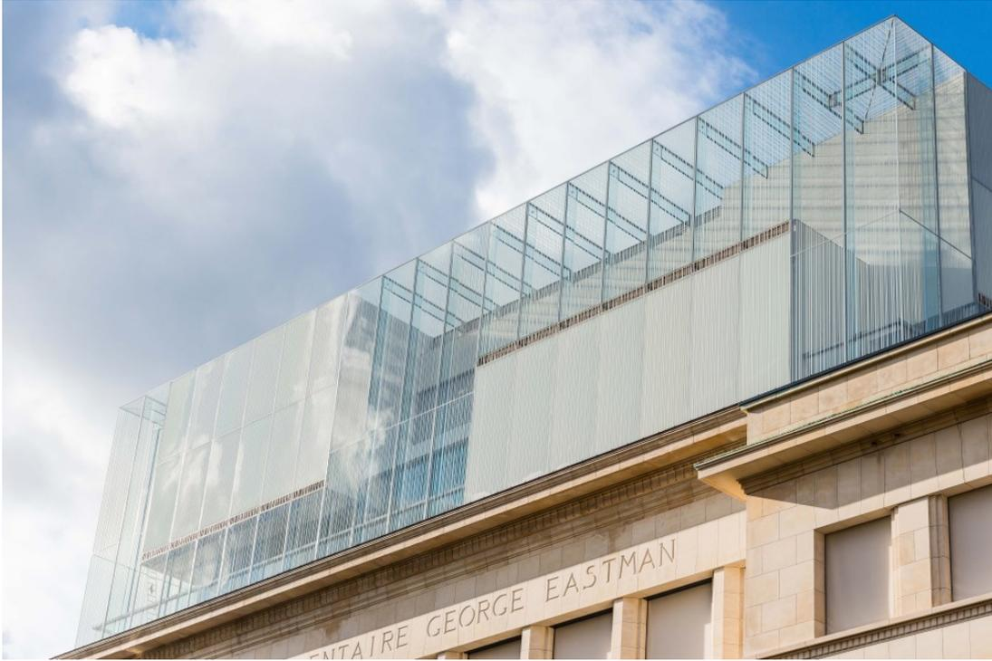
**La nouvelle enveloppe vitrée clôt et couronne le bâtiment. Elle est composée de deux façades qui assurent son efficacité thermique : une façade extérieure, faite de plaques de verre sérigraphié, laissant passer l'air et les vues; une deuxième façade, dite intérieure, composée d'environ 50% de pleins et 50% de vides.**
