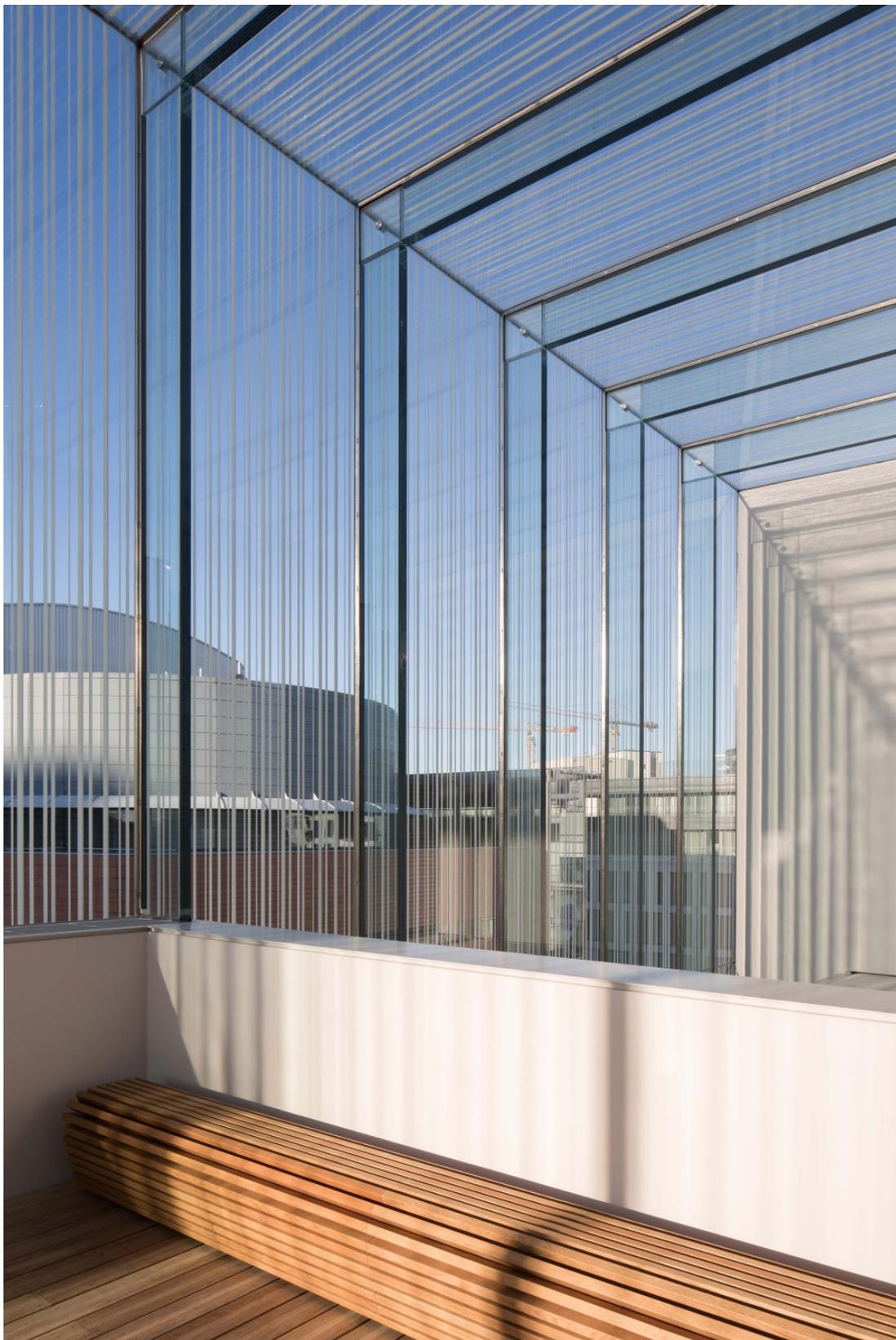
**De 4 à 14 m de haut, d'un seul tenant, les raidisseurs en verre sont composés de 4 à 6 plaques de verre feuilleté de 1cm d'épaisseur. Les verres de toiture sont également portés par un maillage de poutres en verre. La jonction poteaux-poutres se fait par moisage, permettant une liaison délicate et discrète.**
